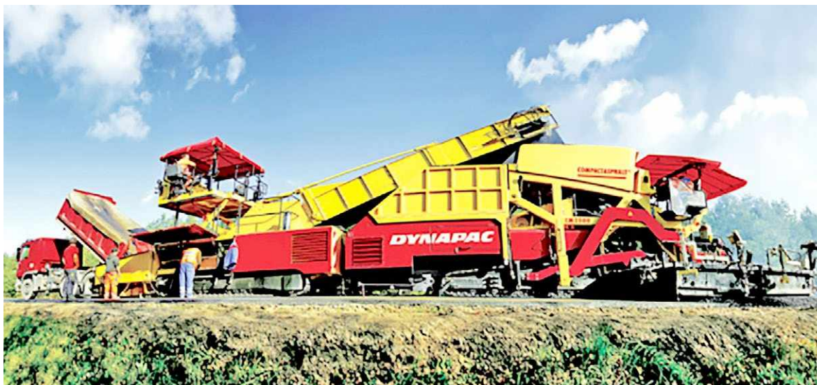
Рис. Укладка асфальтобетонов с применением технологии «компакт-асфальт»
