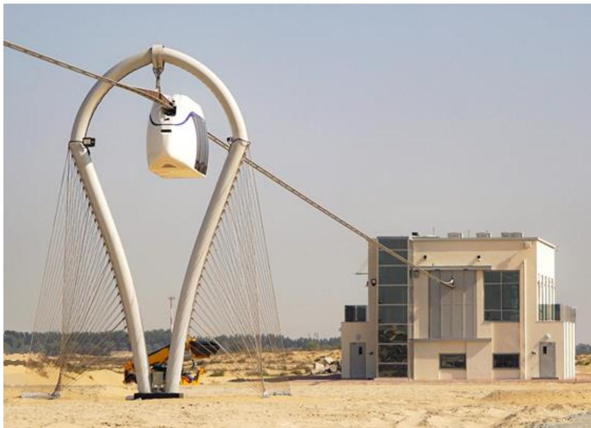
Рис. 10. Гибкая рельсо-струнная путевая структура
