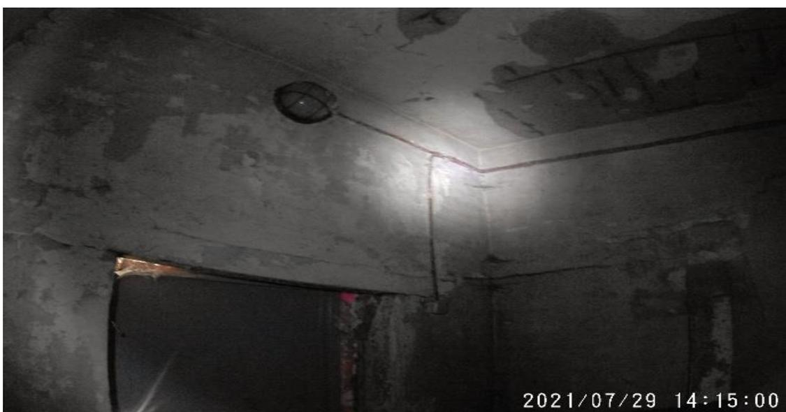
Рис. 1. Дефект, выщелачивание бетона
