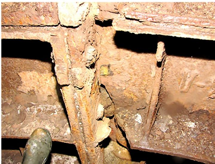
**Рис. 1.** Разрушение ребра тубинга со смещением
