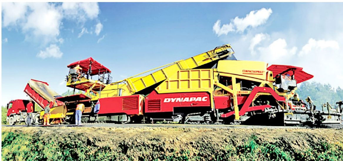
Рис. Укладка асфальтобетонов с применением технологии «компакт-асфальт»
